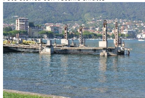
Pontili di Attracco per Chiatte Ferroviarie
