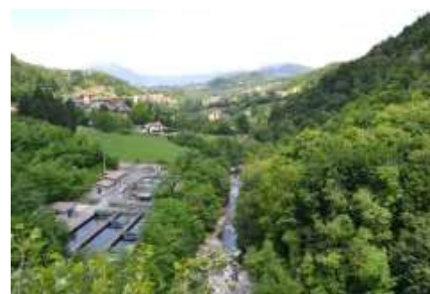
La val Imagna dal ponte del Chitò con l'impianto della depurazione delle acque reflue
