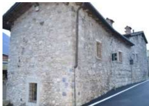
Complesso della Torre del Mazzo di Cene
