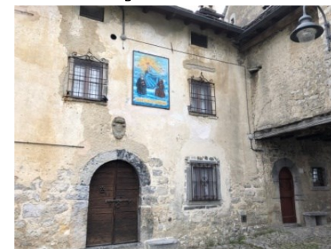
Arnosto, facciata di uno storico edificio
