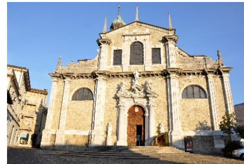
Facciata della Basilica
