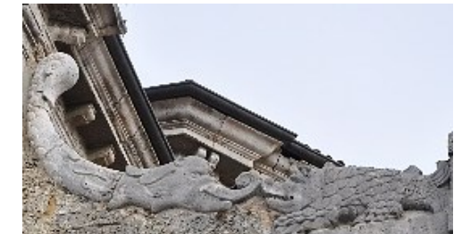
Particolari della facciata
