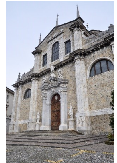
Facciata della Basilica
