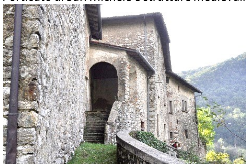
Facciata nord della Chiesa di Santo Stefano
