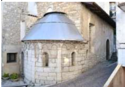
Cambianica, abside dell'Oratorio di S. Michele con la copertura provvisoria attuale
