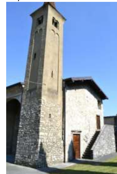
Campanile e facciata della Chiesa di S. Pietro
