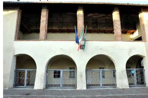
Facciata interna della Cascina Misericordia
