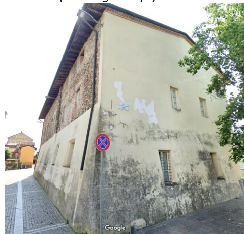
Complesso della cascina Misericordia (da Google Maps)
