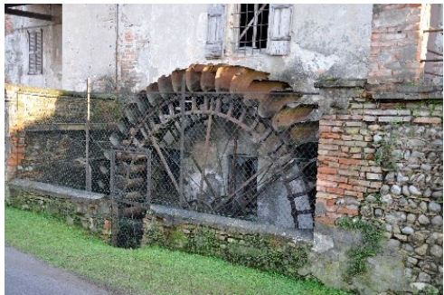
Strutture idrauliche e ruota in ferro del Mulino del Gerro
