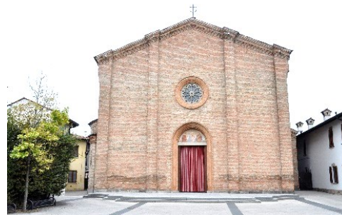
La facciata della parrocchiale
