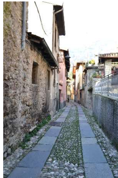
Pavimentazione in acciottolato in cui sono state riproposte le tipiche carrarecce in lastre di pietra
