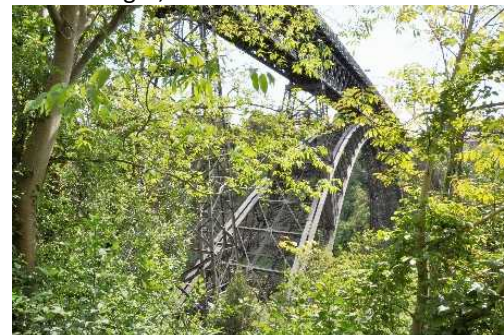
L'Arcata in ferro del Ponte San Michele
