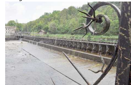
La Diga Vecchia tipo Poirée con i pali di legno
