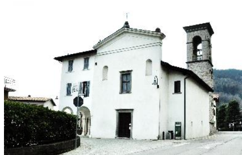
Facciata nord dell'ex Chiesa di San Bernardino
