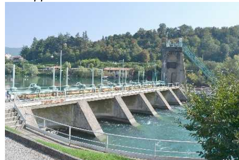
Diga di Sbarramento a valle
