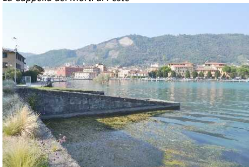
I Pontili di Attracco delle Chiatte Ferroviarie
