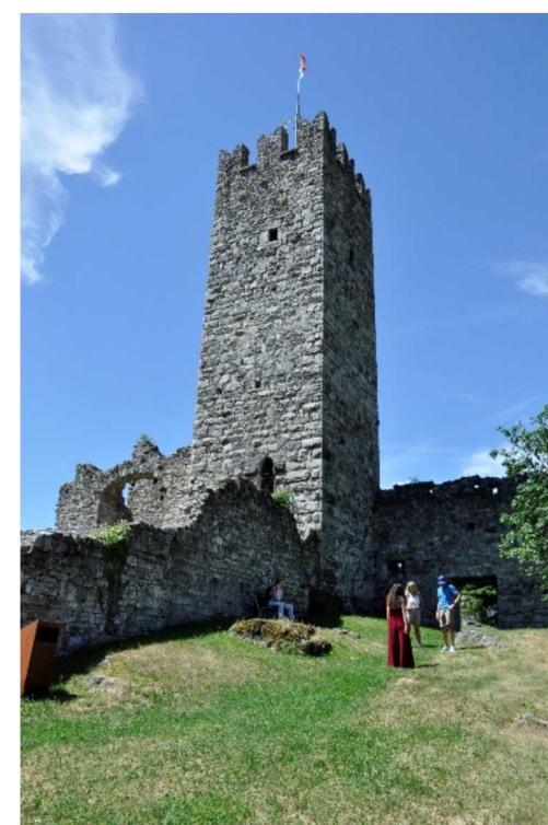
La Torre del Castello
