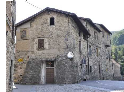
Fortificazione sulla provinciale del XII sec.
