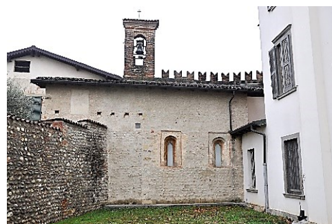
Particolari architettonici nell'area di Palazzo Perini
