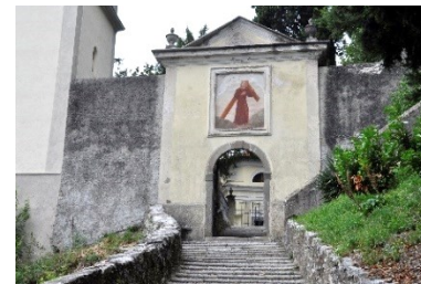
Portale di ingresso dell'Eremo
