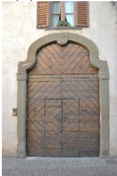
Portale in via Battisti con tracce di fortificazione
