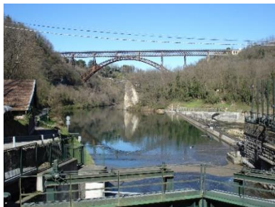
Canale di Paderno, sullo sfondo l'ardito ponte di ferro stradale e ferroviario
