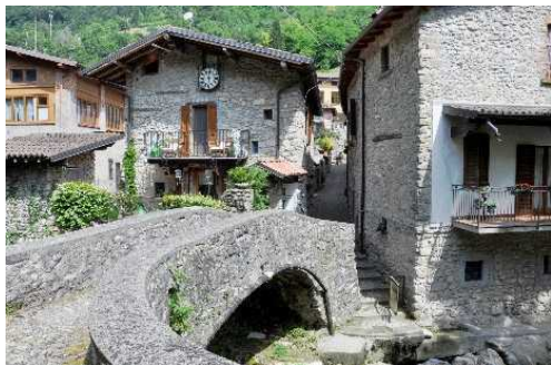
Ponte in pietra alla Contrada Forno
