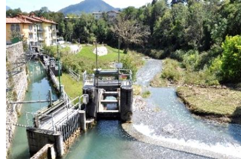
Opere idrauliche al ponte
