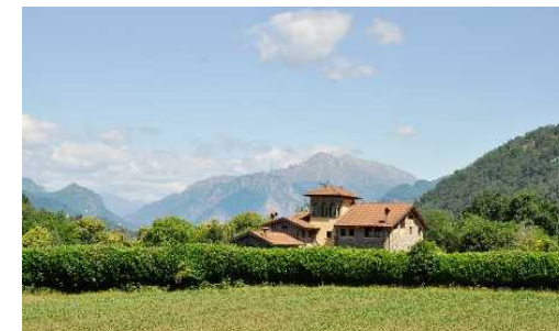
Cascina Selva, edificio recentemente restaurato
