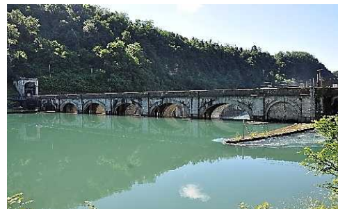
La Diga di Robbiate verso monte
