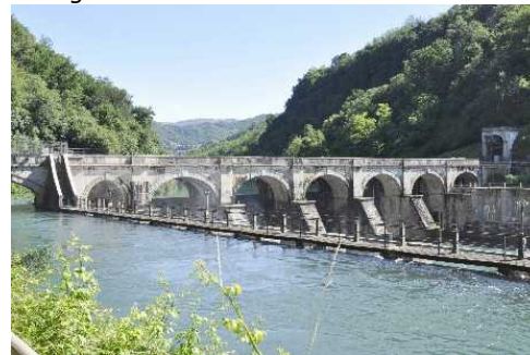
La diga di Robbiate verso valle
